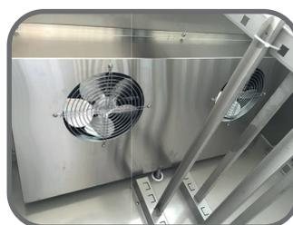
Evaporador de tiro forzado con recubrimiento anticorrosión.
